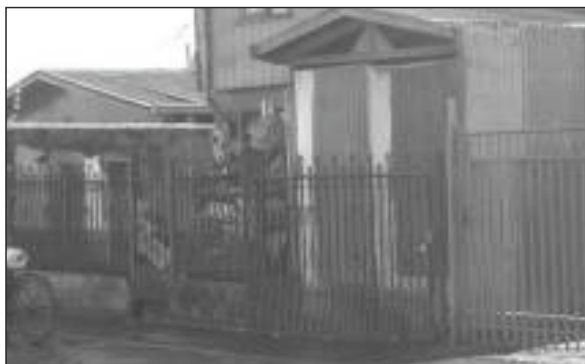
Fotografía 30: Riesgo de la forma de acopio
